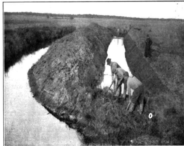
Redressement fait à la pelle à main. Le coût initial sera facilement remboursé par l'économie réalisée dans l'entretien du cours d'eau.
